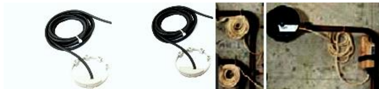
Рис. 9. Монтаж вузла обліку
